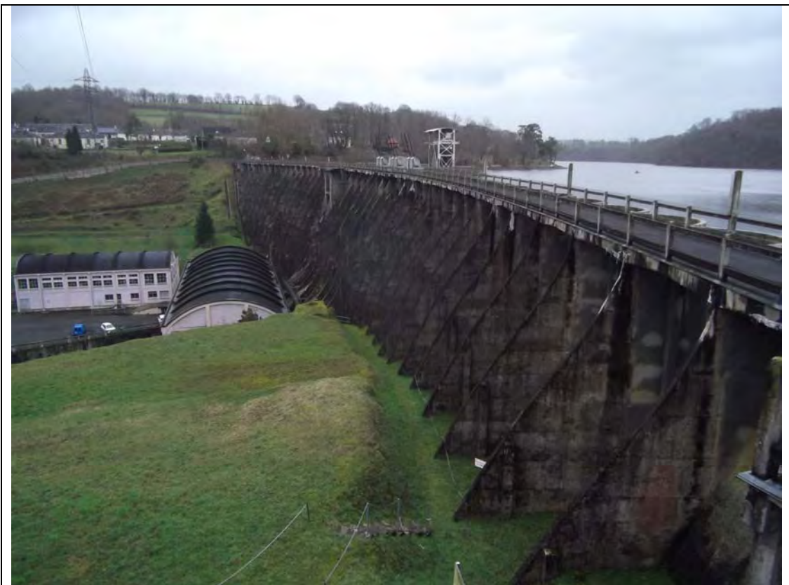
Barrage de Vezins
